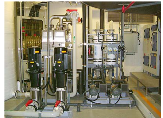
第二级Liqui-Cel 抛光系统去除CO 2 和 O 2
